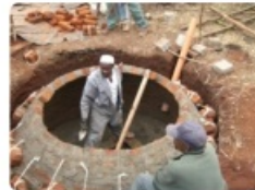
Bau von Biogasanlagen für Haushalte in Kenia
